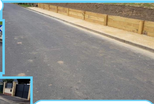
TROTTOIR RUE DE LA FORGE
