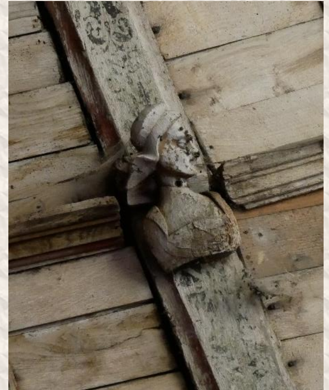
Charpente, transept sud, buste de profil (lacunes)
